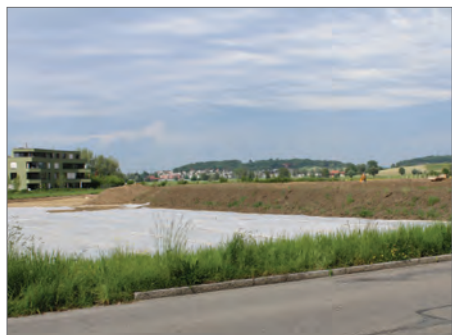
Die Bauarbeiten auf der Hegmatte haben begonnen.
