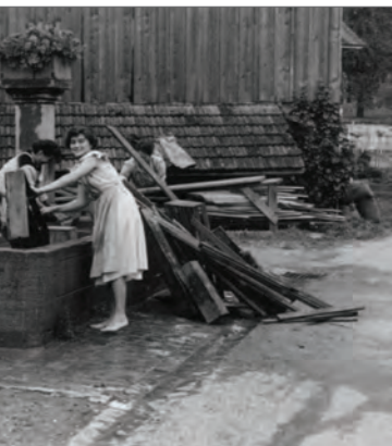
te das grosse Aufräumen.
