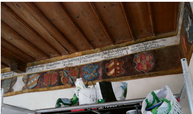
Restoration der Wappengemälde
