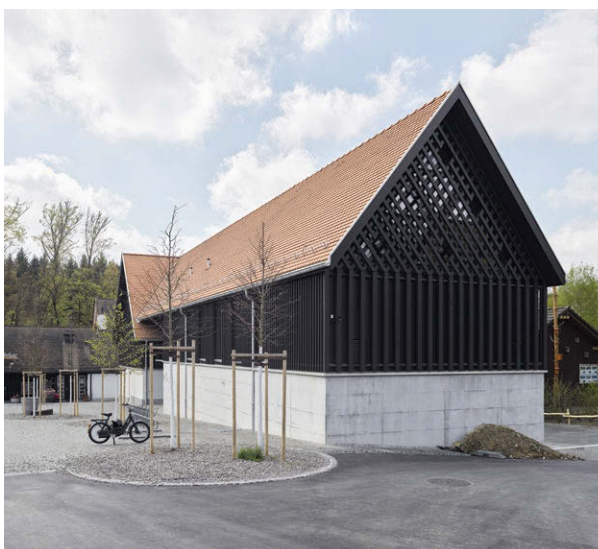
Wildpark Bruderhaus, Holzbau des Tierschutzkompetenz-zentrums «Fauna» der Haldiman Stiftung mit markanter Fassadenstruktur.
