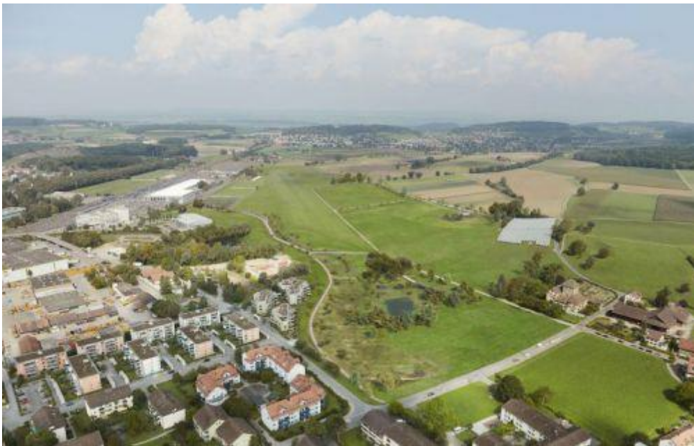
Bildbeschreibung: So soll Hegmatten nach der Erstellung des Hochwasser Rückhaltebeckens aussehen. Quelle: AWEL.
